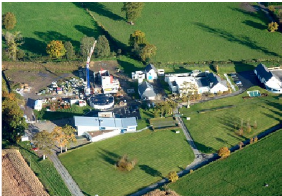
Illustration 13: vue aérienne de l'usine de la Gaubardière, située sur la commune de Saint-Aubion de Terregatte, pendant les travaux d'extension de 2013. (Source SMAEP baie bocage)
